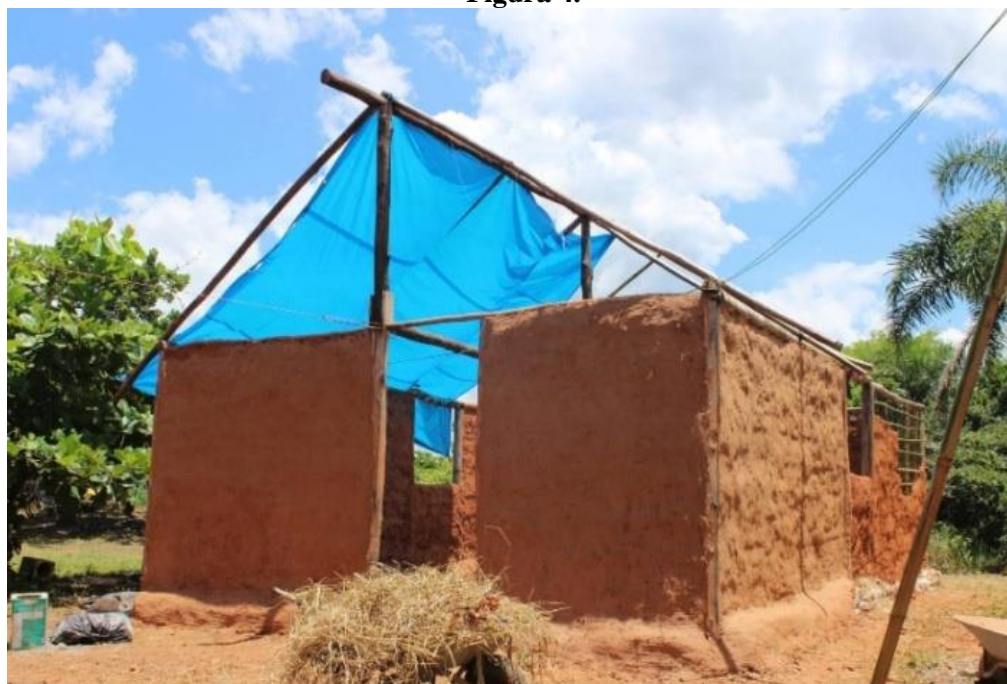
Construção da escola – vivência da permacultura. Fotografia: Arquivos Vivência na aldeia, 2015.
